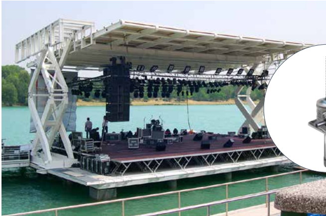
Optimierte Spindelhubelemente von Pfaff-silberblau heben und senken das Dach der Mailänder Seebühne zuverlässig und vor allem sicher.
