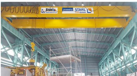
Kaum vorstellbar, dass der stabile Kran mit einer Spannweite von 24 Metern erst am Einsatzort aus drei Teilen zusammenmontiert wurde.
