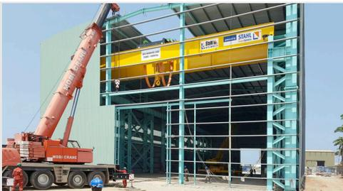
Ein interkontinentales Projekt: in dem neuen Werk von General Electric in Ghana wird die Krananlage von Stahl Cranes & Hoists aus Südafrika mit der Technik von STAHL CraneSystems aus Künzelsau aufgebaut.
