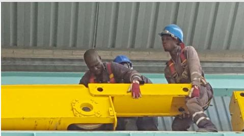
Die drei Einzelteile des Krans werden von einem fachkundigen Team zusammengesetzt.
